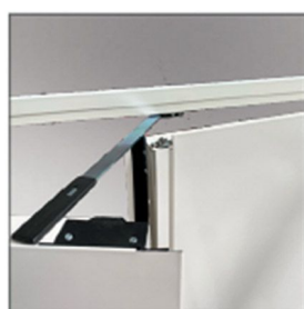
Sélecteur de fermeture pour les portes 2 vantaux.
