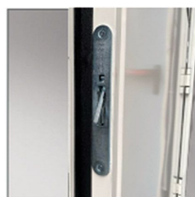
Contre serrure avec verrouillage haut et bas intégrée dans semi-fixe et butée de sol (porte 2 vantaux).
