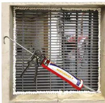
Lors de l'installation, la périphérie de la grille doit être colmatée à l'aide du mastic **ACRYLODICE F**.
